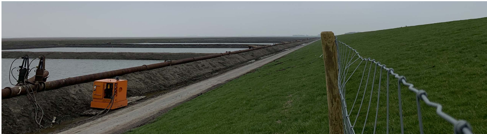
Figuur 17. De Brede Groene Dijk, versterkt met slib uit de Eems-Dollard, dat droogt tot klei in de naastgelegen kleirijperij
