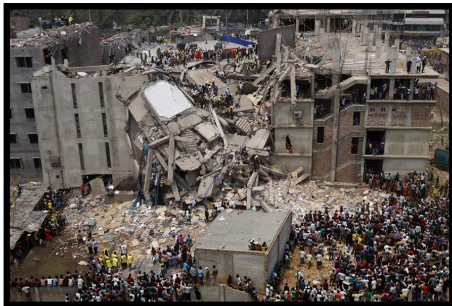
Figuur 7: ineenstorting van textielfabriek op Rana Plaza.
