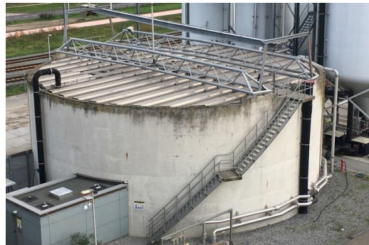
Figuur 3 - Dijkversterking Lauwersmeerdijk (links) en afdekking slibbuffer (rechts)
