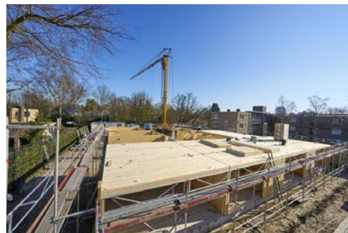
Bouwproject WonenZoals in 's-Hertogenbosch in aanbouw, CLT (kruislaaghout), van Brabant Wonen in samenwerking met Hendriks Coppelmans. (foto Hendriks Coppelmans)
