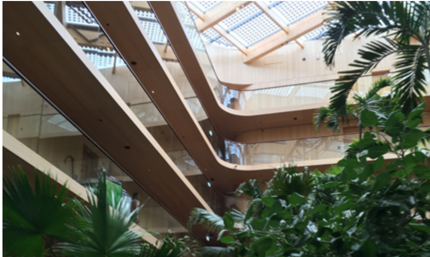
Funciecombinaties besparen op materiaal en kosten. De zonnecellen in het glas bij Hotel Jakarta (Amsterdam) leveren stroom, het glas eromheen daglicht voor de weelderige beplanting in het atrium van het hotel. Ontwerp: Bjarne Mastenbroek.
