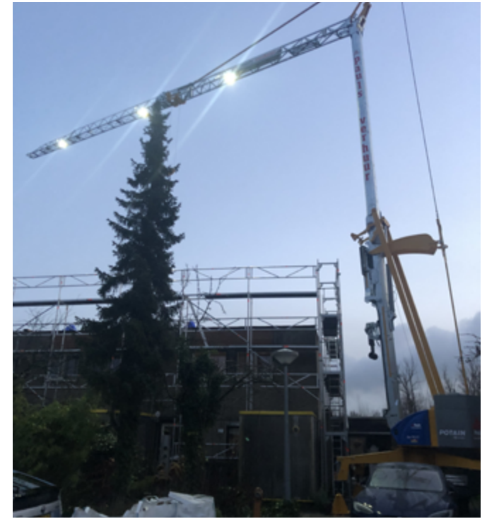
De elektrische kraan veroorzaakte geen stikstofuitstoot en kon eenvoudig bouwmaterial naar het dak hijsen.
