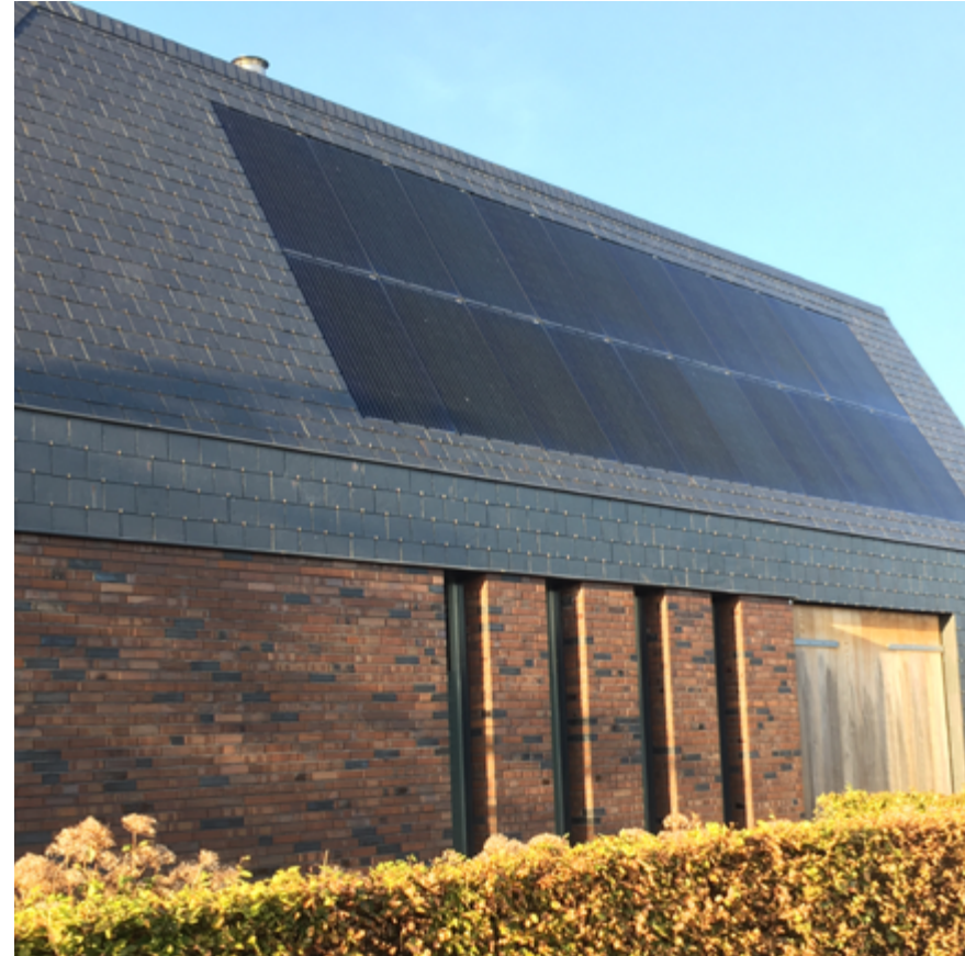
Architecten kunnen zonnecellen vanaf de eerste schets meenemen in het ontwerp. Daarmee voorkomen ze dat de zonnesystemen er achteraf op een lelijke manier 'opgeplakt' worden.
