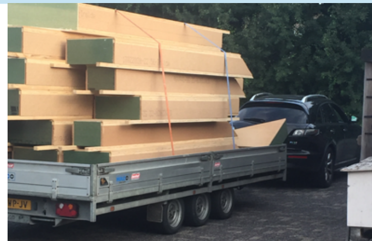
Bouwelementen van 60 cm breed hebben als voordeel dat ze eenvoudig en betaalbaar op een aanhanger te vervoeren zijn. Foto: Dior Bouw.
