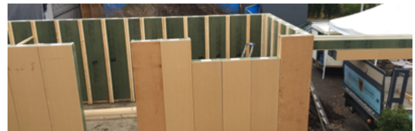
Holle bouwelementen (BB Block) kunnen met verschillende biobased isolatiematerialen gevuld worden; bij dit project zijn paprikastengels gebruikt.
