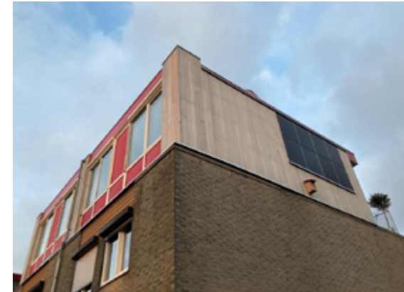
Zonnecellen op de zuidgevel zullen ook in de winter, wanneer de zon laag staat, stroom produceren. Per m 2 is er gemiddeld 25kWh energie-instraling in de maand december.
