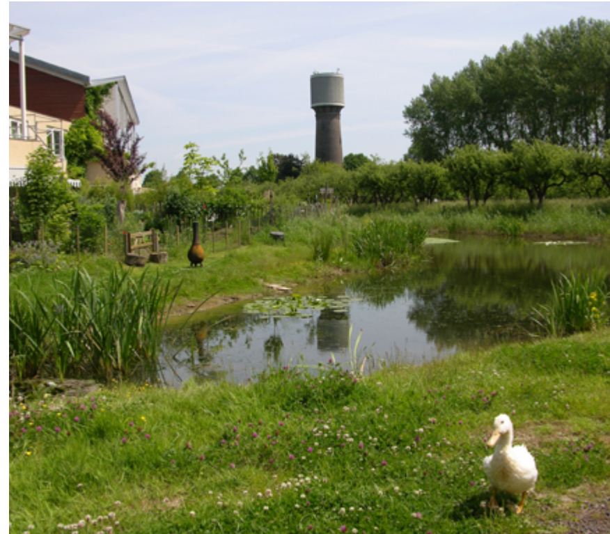
Wadi's zijn een beproefde manier om overvloedige regenval te kunnen bergen; waterberging is goed te combineren met groenvoorzieningen. EVA Lanxmeer, Culemborg.
