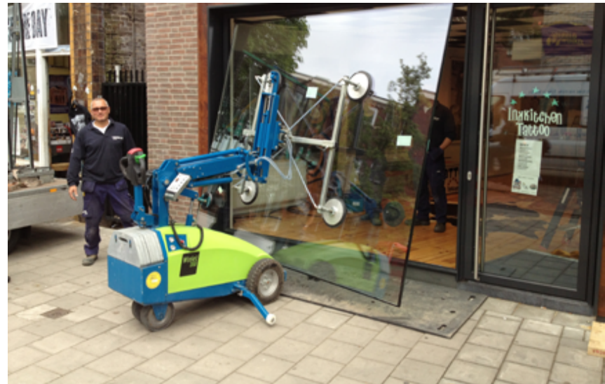
Robots voor het eenvoudig (ver)plaatsen van glas, plaatmaterialen en deuren zijn al jaren op de markt, het grootschaliger toepassen ervan draagt bij aan betere arbeidsomstandigheden op de bouwplaats en verhoging van de arbeidsproductiviteit. Foto: Montarent.
