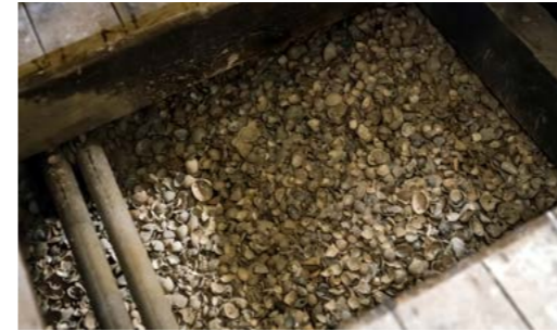
Bodemisolatie / kruipruimte isoleren
