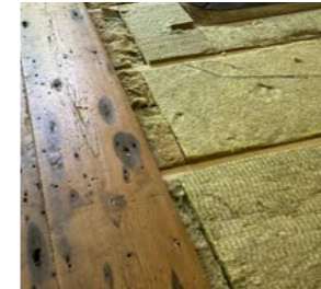
Bestaande vloer aan de bovenzijde isoleren
