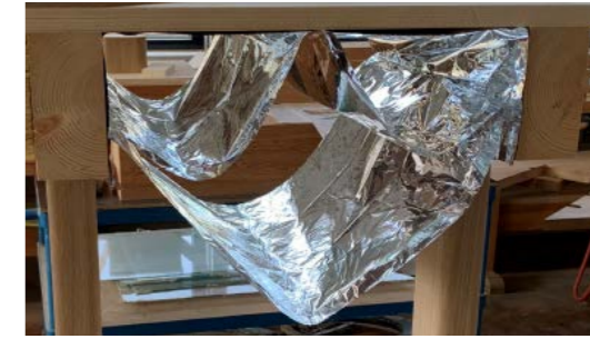
Vloer direct aan de onderzijde isoleren
