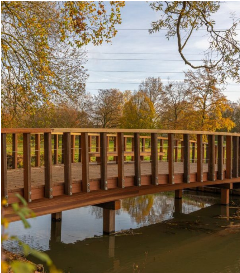
Afbeelding 5: Fiets- en voetgangersbrug Gerrit Schultepad in Nijmegen, deels gemaakt van nieuw Azeobé hout en hergebruikt tropisch hardhout.
